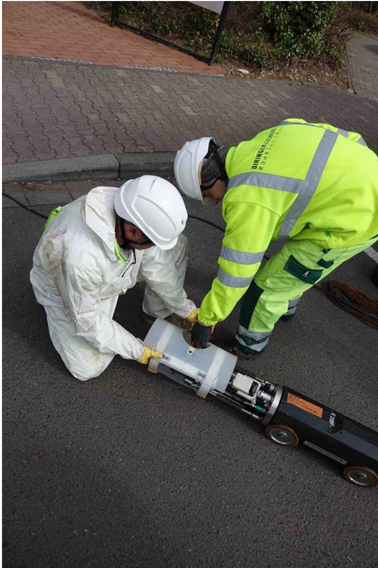
Heiko Wolfram und Christopher Schubath bereiten die PI.TRON Spachtel- und Verpresseinheit für den Einsatz zur Reparatur eines Anschlusses vor.
