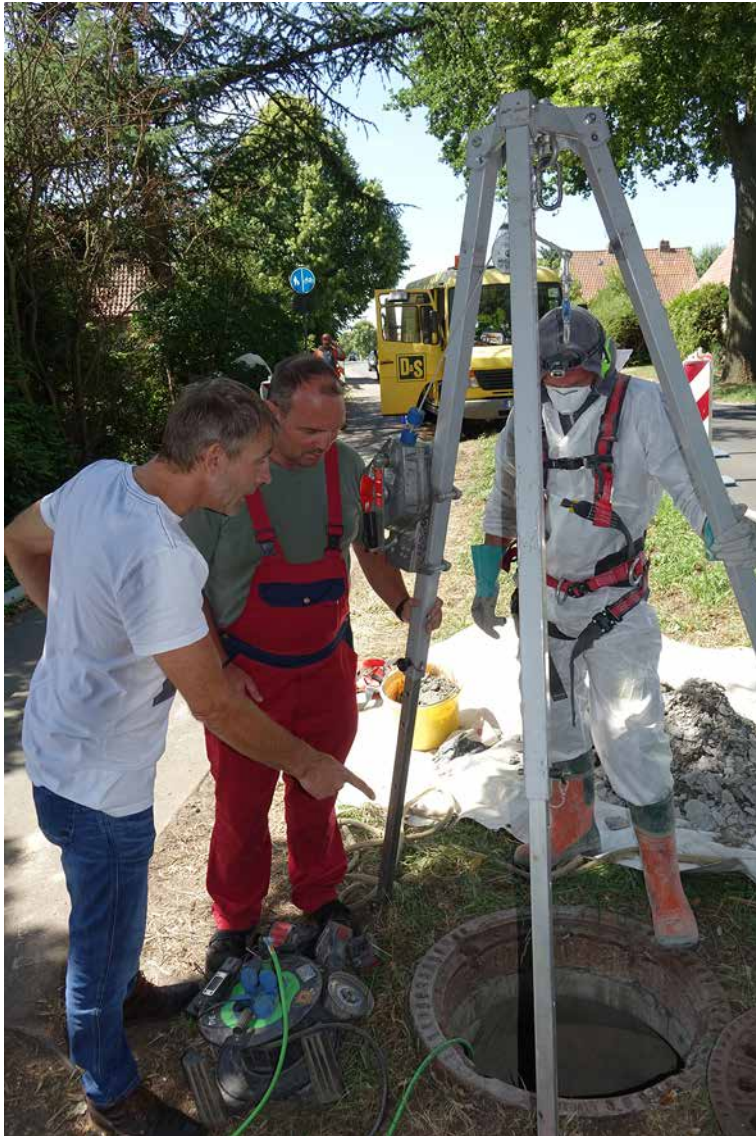
Hans-Jürgen Niemann (Gemeinde Beverstedt), Frank Riegel (Gemeinde Beverstedt) und Matthias Spatzier (D&S Rohrsanierung) (v.l.) beobachten den Fortschritt des Berstlinings am Startschacht.
