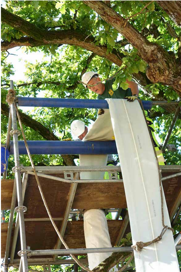
Auf dem Inversionsturm überwachen die Arbeiter den fachgerechten Einbau des Liners.
