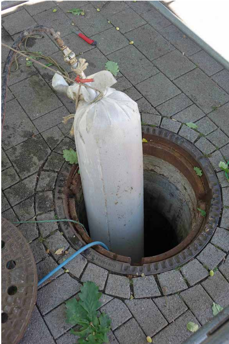
Einzug des gewebeverstärkten PVC-Preliners.
