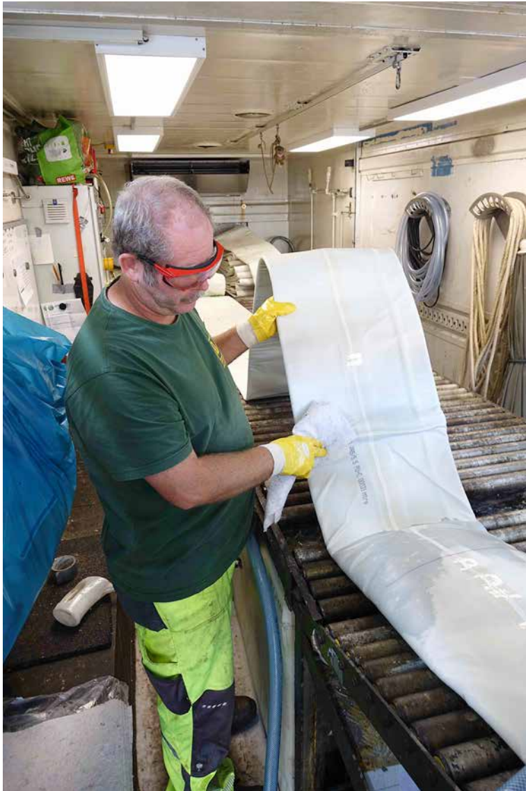
Jürgen Trenz, D&S Rohrsanierung, überwacht den Tränkvorgang im DS CityLiner.
