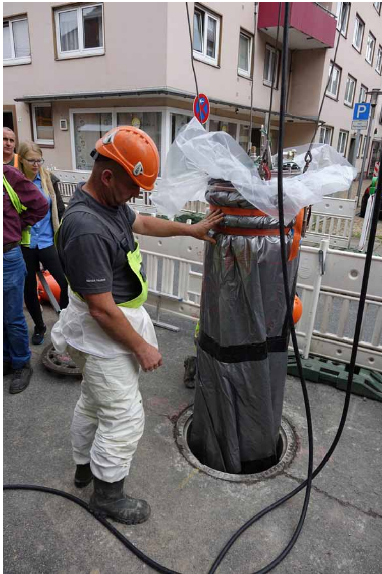
Einhängen der Schachtauskleidung.
