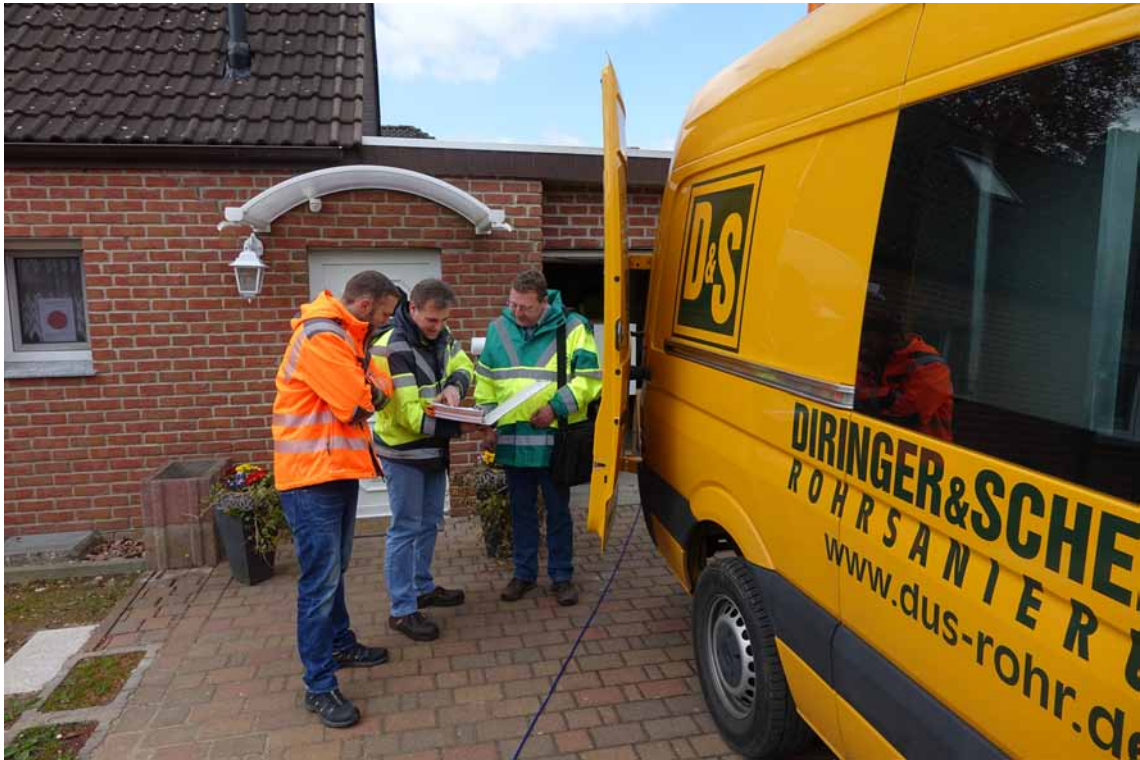
Schwieriges Terrain: Teile der zu sanierenden Kanalisation lagen unter privaten Grundstücken und Bebauung.
