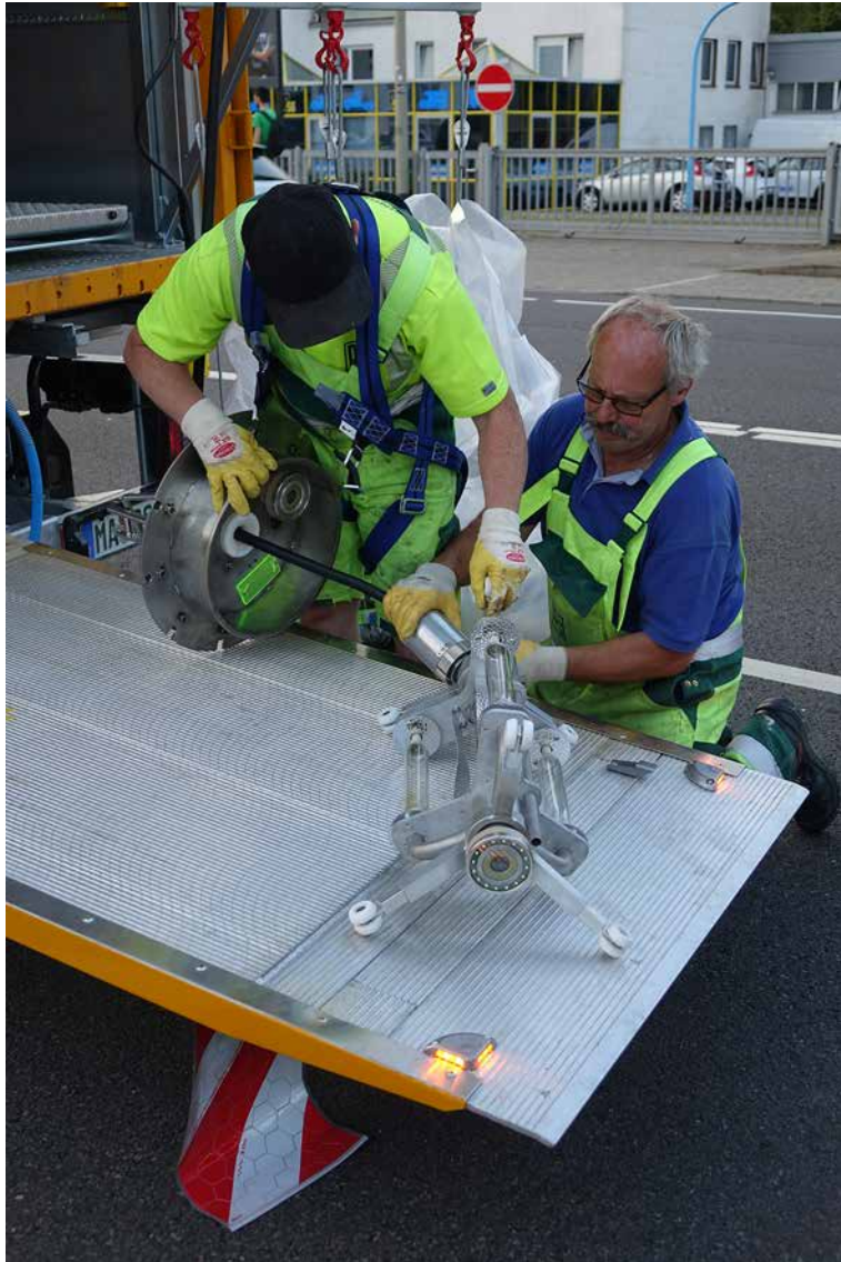
Die UV-Lichtquelle wird unterhalb der Abdeckung installiert.
